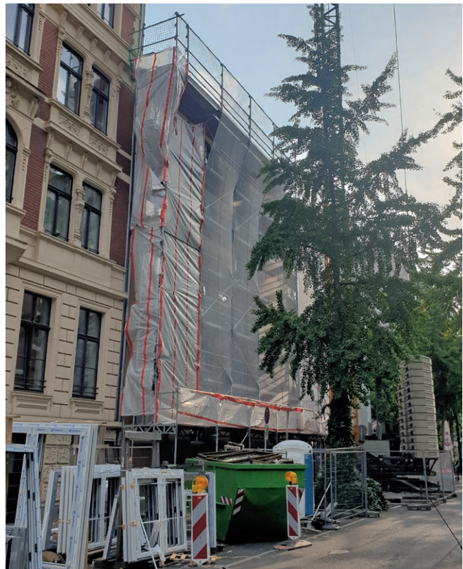
Abb. 1: In Innenstädten ist es schwer, modular zu bauen, um damit das Bauen zu beschleunigen. Oft fehlt der Platz, um vorgefertigte Bauteile anzuliefern und zusammensetzen. Es kann nur konventionell gebaut werden. (Fotos: Bernhard Hoffmann)
